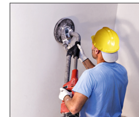
Innenwand-/Putzoberfläche, Wandfarbe abschleifen
