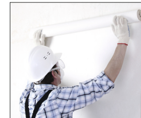
EQ-TOP anbringen, Überlappung 20 cm, mit EQ-GLUE überarbeiten
