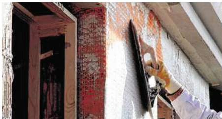
Das „EQ-Grid“-System der Firma Kast ist ein Gewebenetz, das in der Gebäudefassade verputzt wird und für Stabilität sorgen soll (links). Christoph Kast (rechts) ist seit 1994 Geschäftsführer der Günther Kast GmbH. Fotos: Kast (Archiv)
